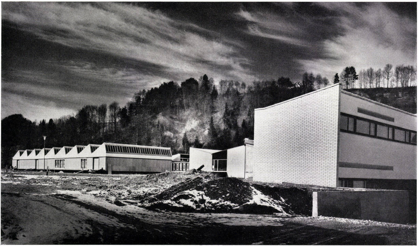
Ansicht der Lagerhalle und des Kesselhauses von Nord-west. Vue de l'entrepôt et des chaudières, pris du nord-ouest. View of depot and boiler house from north-west.
