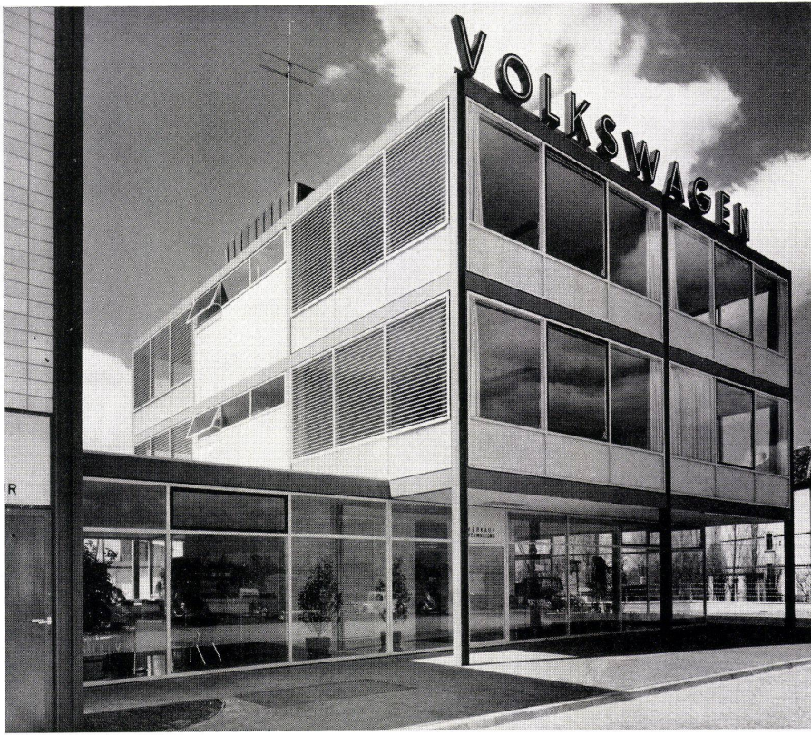
Bürohaus mit Verbindung zur Shedhalle. Bâtiment des bureaux et couloir vers la salle à toiture shed. Office building with passage to shed.
