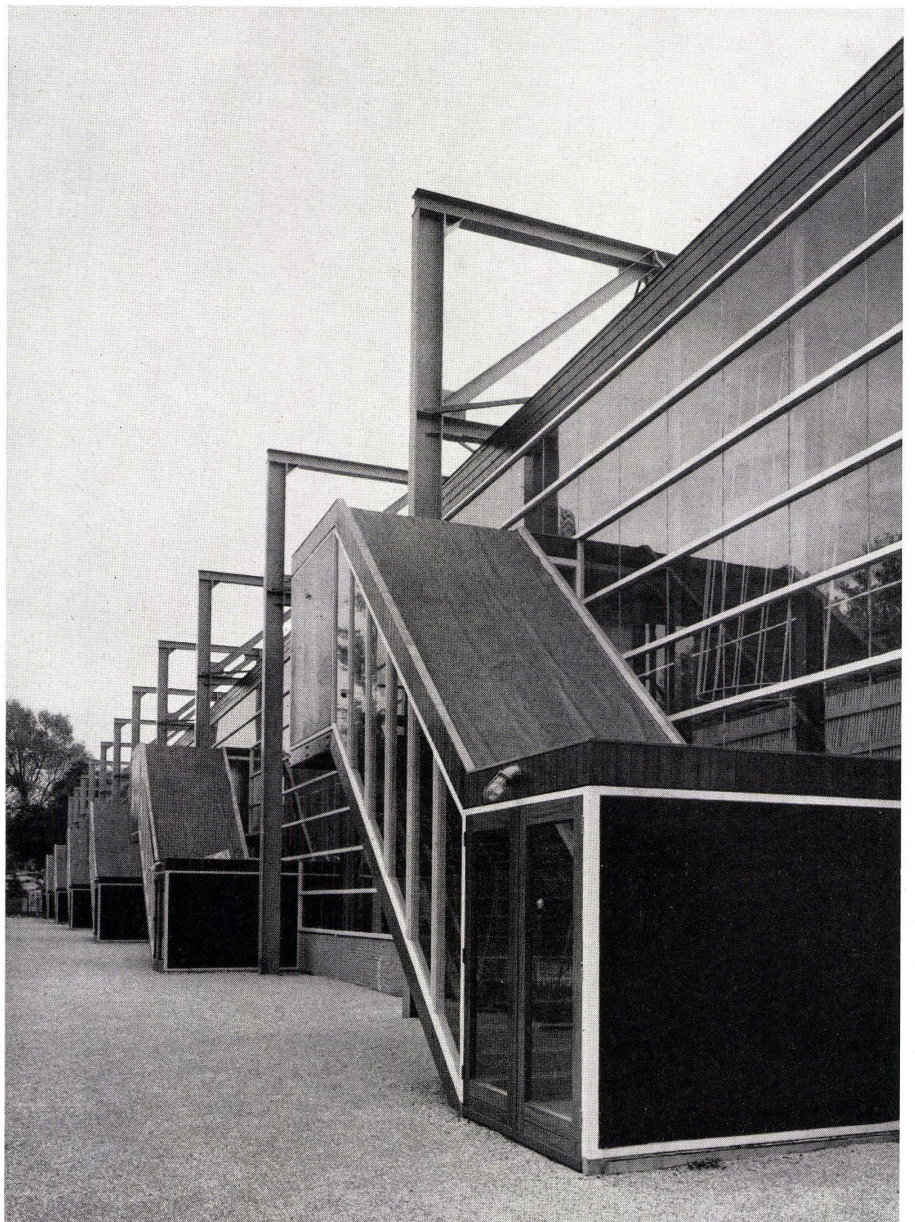
Ostseite der Sporthalle. Trennung von Konstruktion und Raumabschluß. Gedeckte Tribünenaufgänge. Côté est de la salle des sports. Séparation de la construc- tion et de la paroi. Accès couverts à la tribune. East side of sport hall. Separation of construction and outside wall. Covered accesses to galleries.
