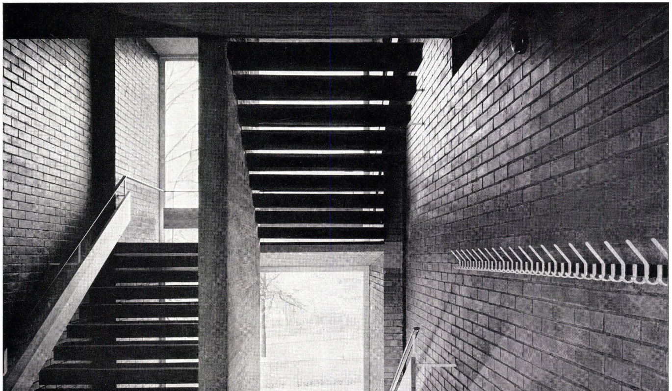
Treppenhaus mit Garderobenhaken. Cage d'escalier et vestiaire. Stair-well with cloakrooms.
