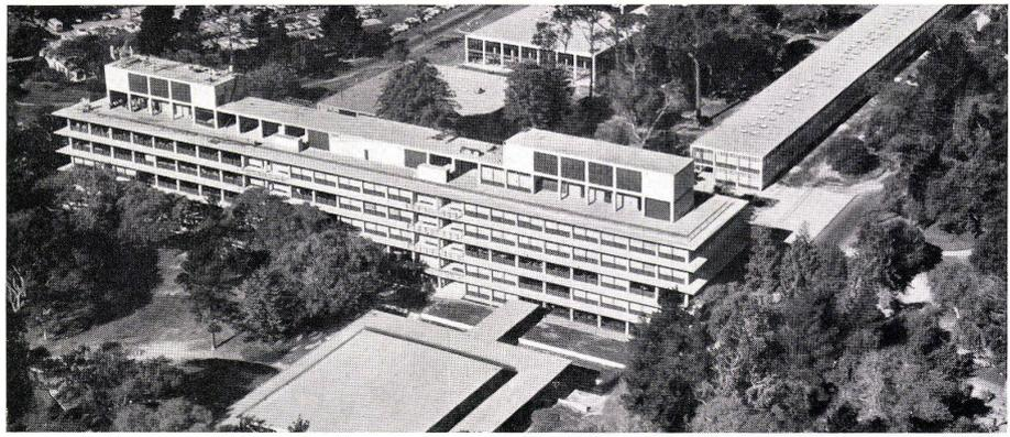
Das Auditorium ist ein einzelner Bau innerhalb eines ganzen Komplexes der United States Post-Graduate Naval Training School (Marine-Ausbildungszentrum) in Monterey. Der Saal, der 1200 Zuschauer faßt, ist unter das Erdniveau versenkt. Die Deckenkonstruktion besteht aus vorgegossenen Betonträgern über nur vier kreuzförmigen Stützpfählern.
