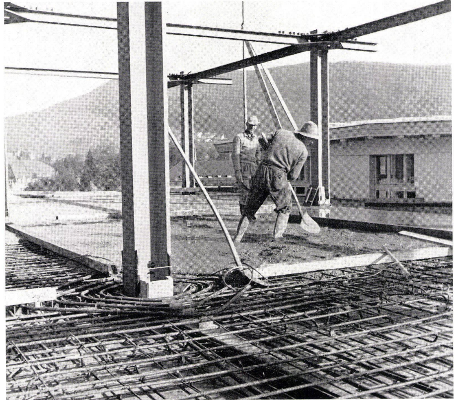
3 Deckenarmierung. Armure du plafond. Ceiling reinforcement.
