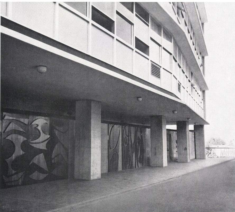
Detail der Eingänge zur Haupthalle und zu den Ausstellungsräumen des Erdgeschosses.
