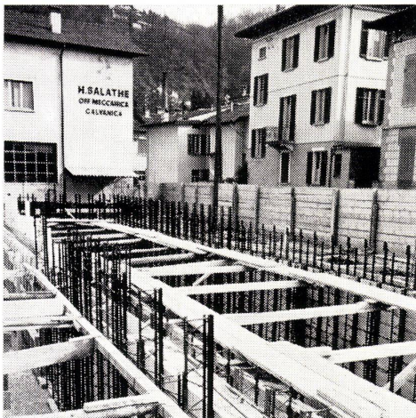
Fixträger für Vertikalschalung
