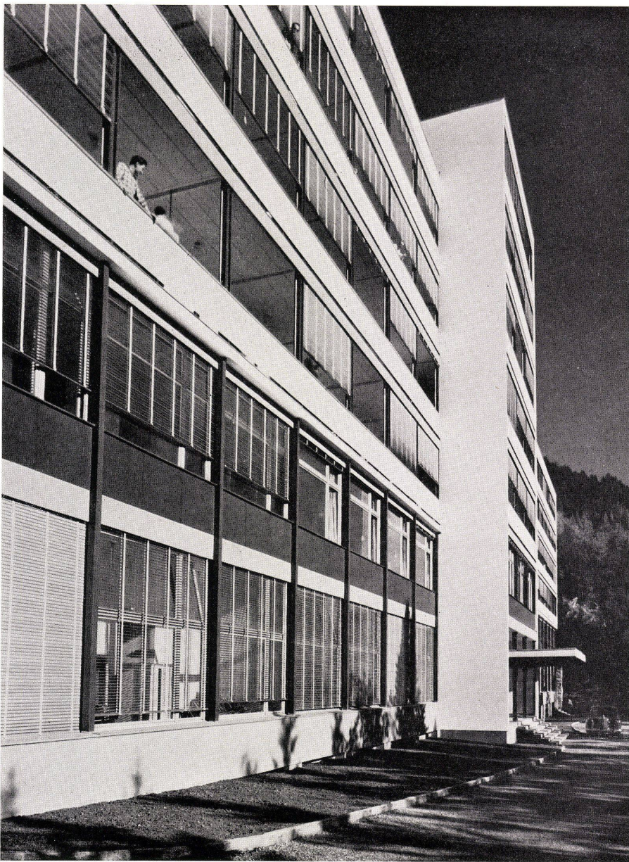
1 Detailaufnahme der Südfassade, unten die Aufenthaltsräume, in den oberen Stockwerken die Veranden der Krankenzimmer.
