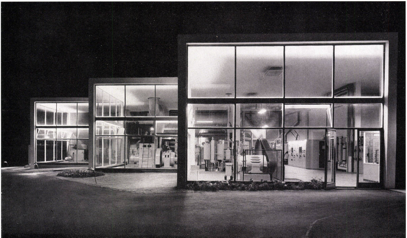
Blick in die Maschinenhalle bei Nacht. Vue de la salle de machines prise la nuit. View of machinery shed at night.
