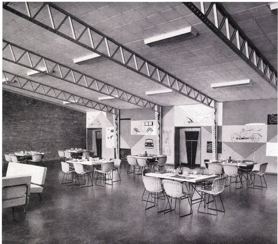
5 Inneres des ersten Speisesaals mit waagrecht Brise-soleil. Außerordentlich leichte Aluminiumfachwerkträger überspannen den Saal. Dasselbe Konstruktionsprinzip ist für die Pfeiler angewandt. Intérieur de la première salle à manger à brise-soleil horizontaux. Des poutres à treillis d'aluminium extrêmement légères sont jetées sur la salle. Le même principe de construction a été appliqué aux piliers. Interior of the first dining-room with horizontal sunbreak. Exceptionally light aluminium lattice girders over hall. Same construction principle applied to piers.
