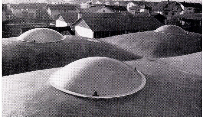
Großlichtkuppeln von 5 m Durchmesser, hydraulisch hebbbar
