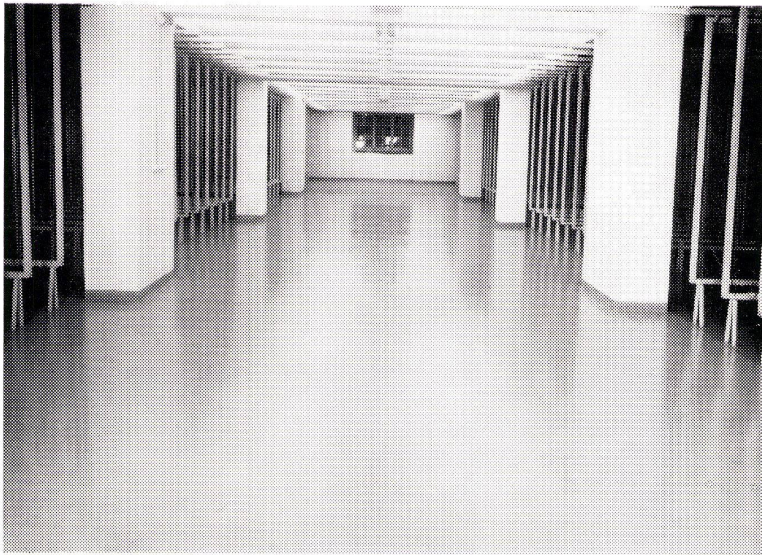
Granitol DD-Lack im Bildermagazin und Kautschuklacke in den Kellerräumen des Kunsthauses Zürich
