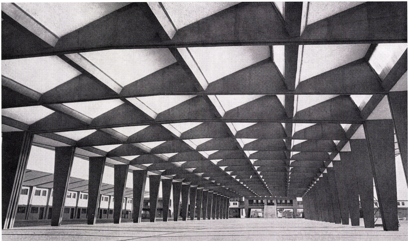
Dachuntersicht der Großmarkthalle (siehe Konstruktionsblatt). Face inférieure du toit des halles (Voir plan détachable). Underside of roof of market shed (See design sheet).
