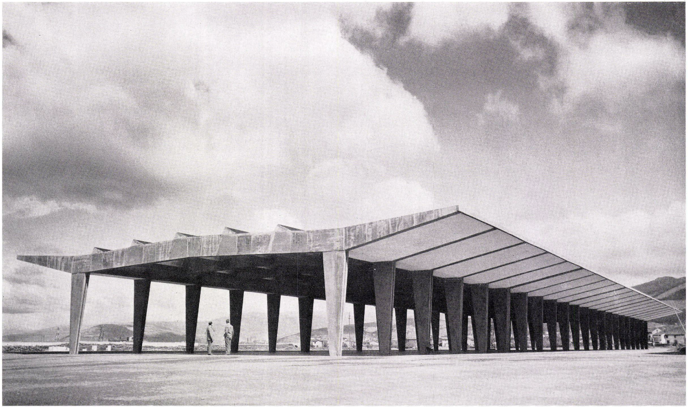
Ansicht der Großmarkthalle. Vue des halles du marché de gros. View of wholesale market.
