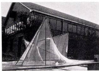
1 Gerippe aus Rohren und engmaschigem Metalldrahtgewebe zur Anfertigung des Gipsmodells vom Philips Pavillon, im Maßstab 1:25 (Institut T.N.O. in Rijswijk, Niederlande).
