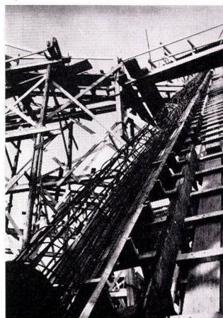
8 Die Spanndrähte einer Rippe, montiert vor der Herstellung der Verschalung und dem Schütten des Betons. In dieser Rippe waren nur Drähte zur Erzeugung einer Torsionsvorspannung angebracht (acht Drähte, verlegt auf dem Mantel eines aus zahlreichen eisernen Reifen gebildeten Zylinders von 35 cm Durchmesser). Die Stahldrähte sind 9 mm dick; sie scheinen hier noch viel dicker, da sie bereits mit der Masse umhüllt sind, die nach dem Guß der Rippe die Haftung an den Beton verhindern soll.
