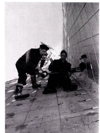
10 Das Anziehen eines Spanndrahtes mit der «Strabed»-Schraubenwinde. Die Zugkraft wird mit dem Dynamometer kontrolliert.
