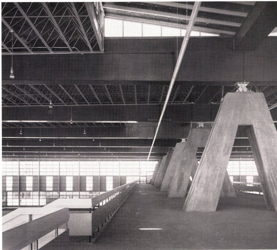
1 Betonsäule zur Aufnahme der Stahlträger in der Halle 1. Pilier de béton supportant le sommier d'acier dans la halle 1. Concrete pillar to receive steel girder in hall 1.
