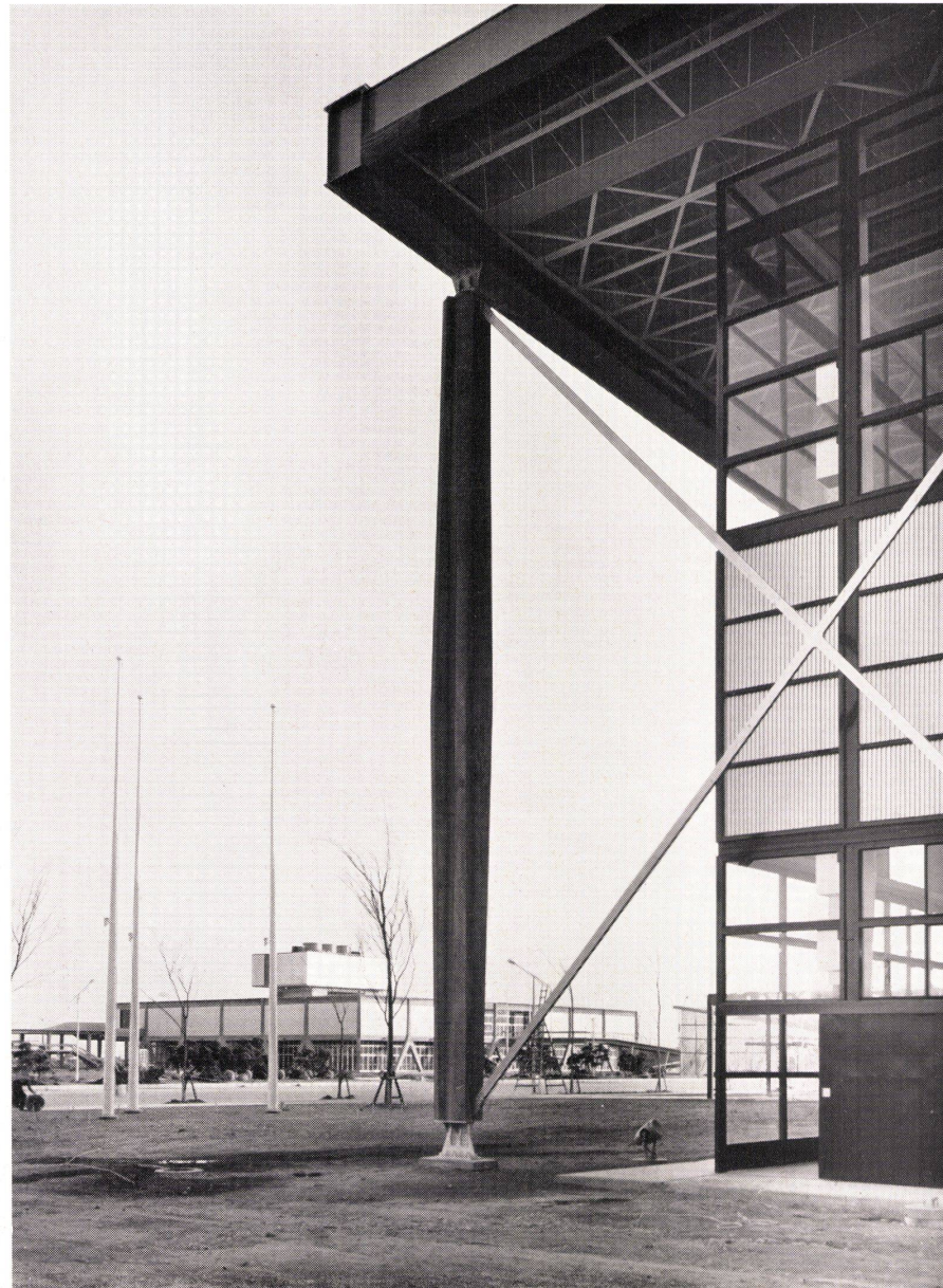
4 Vorfabrizierte Pendelsäule aus Stahlbeton der Halle 1. Im Hintergrund Halle 3. Colonne articulée préfabriquée en béton d'acier de la halle 1. Au fond halle 3. Prefabricated column with ball and socket seating of steel concrete of hall 1. In the background hall 3.
