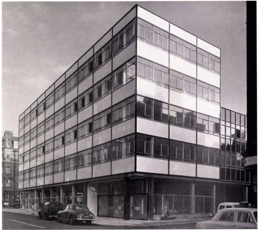
1 Gesamtansicht. Der Bau ist um ein Stockwerk höher als die bestehende Bebauung der Umgebung. Das Erdgeschoß ist nur zu einem kleinen Teil (Eingang) überbaut. Vue générale. L'édifice est d'un étage plus haut que les maisons de l'alentour. Le rez-de-chaussée n'est fermé qu'en partie seulement (entrée).
