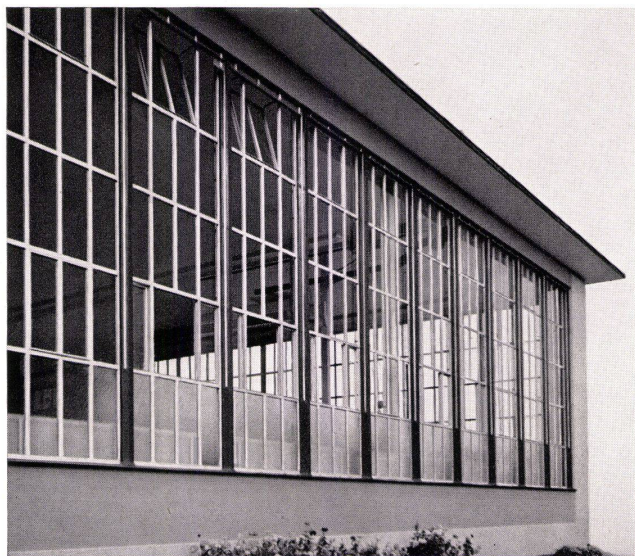
ALSEC-Leichtmetallprofile K = 2,25 – 2,5 Isolierglas-Elemente K = 2,5 – 3,0
