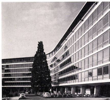
2 und 3 Fassadenausschnitte mit Sonnenschutz (siehe Konstruktionsblatt). Différentes parties de façade avec brise-soleil (voir plan détachable). Elevation details with sunbreak (see design sheet).
