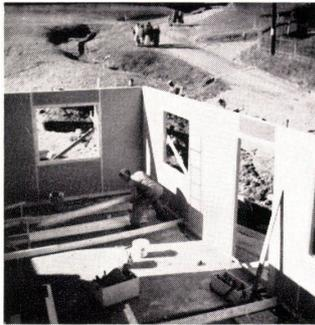
Die Kombination einer 18 cm starken Backsteinmauer mit 4 cm Spritzschaum und 6 cm Zelltonplatten hat unter Berücksichtigung der Gleichgewichtsfeuchtigkeiten der Baumaterialien eine Wärmedurchgangszahl von  $0,52 \text{ Kcal/m}^2 \text{ h}^\circ \text{C}$ .
