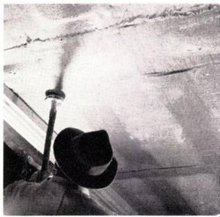
Diese Ausführungstechnik erlaubt es, bestehende, mangelhaft isolierte Hohlwandkonstruktionen nachträglich zu isolieren und damit aufzuwerten. Sehr häufig werden Wände auf folgende Weise mit Spritzschaum isoliert: auf die bestehende Tragmauer wird innen oder außen der Schaum frei im entsprechenden Abstand aufgetragen. Nach einigen Stunden werden innen 6 cm Zetonplatten, außen 12 cm Backsteine vorgemauert.
