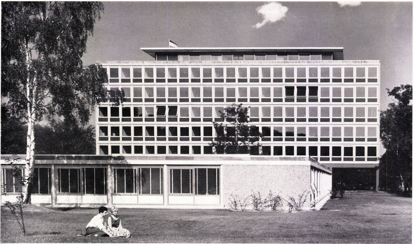
Ansicht von Südwesten. Vue du sud-ouest. Southwest view.
