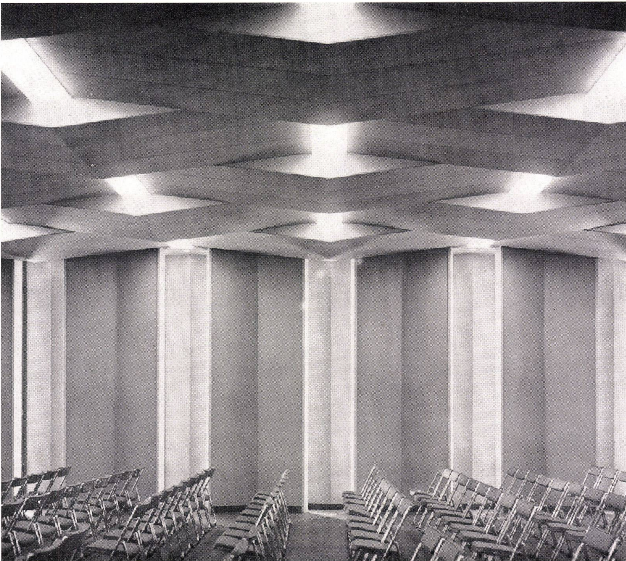
Ausschnitt von einer Außenwand und der Akustikdecke im Theatersaal. Partie d'un mur extérieur et plafond acoustique de la salle de théâtre. Detail of an exterior wall and of the acoustic ceiling in the theatre.
