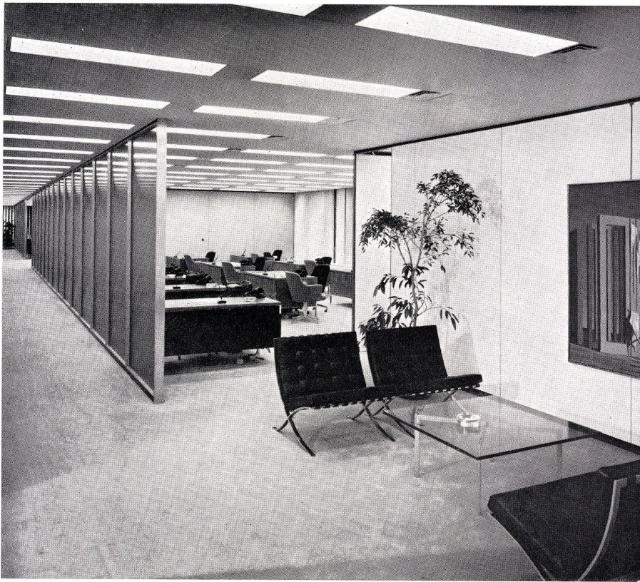
1 Blick aus einer Besprechungsecke in eines der offenen Büros. Man beachte die Lösung der Decke, wo neben leuchtenden Deckenteilen Austrittsöffnungen für die Klimaanlage liegen.
