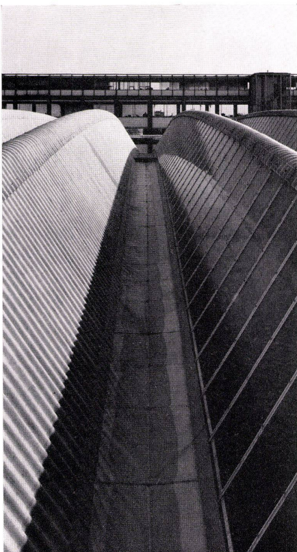
2 Dach des Flachbaus. Kittlos verglaste Oberlichter nach Norden. Südseite mit Well eternit verkleidet. Toit du bâtiment plat. Vitrages supérieurs orientés vers le nord sans mortilage. Côté sud revêtu d'éternit ondulé. Roof of flat building. Puttyless glazed skylight to the north. South side clad with corrugated asbestos-cement.
