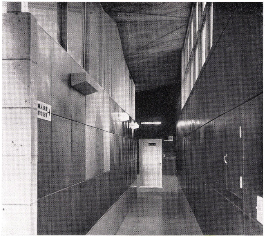
Korridor im Badehaus. Wände aus vorfabrizierten Beton- elementen. Das Dachgefälle ist an der Decke sichtbar gemacht. Schalungsroher Beton. Corridor dans le bâtiment de bain. Corridor in the bath house.
