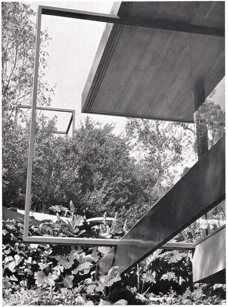
1 Rahmendetail, in welches die Eingangstüre beim Öffnen eingefügt wird.
