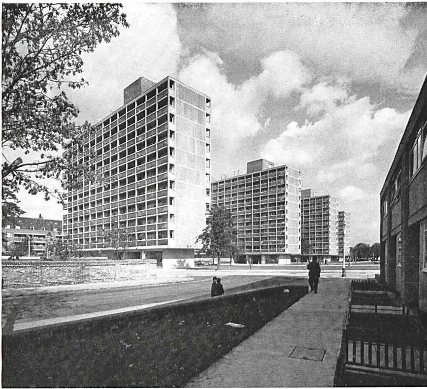
1 Vier 11-Stock-Blocks mit 2-Zimmer-Normalwohnungen, von Südwesten gesehen. Die Vorfabrikation aller Fassadenelemente ergibt strenge, klare Architekturverhältnisse.
