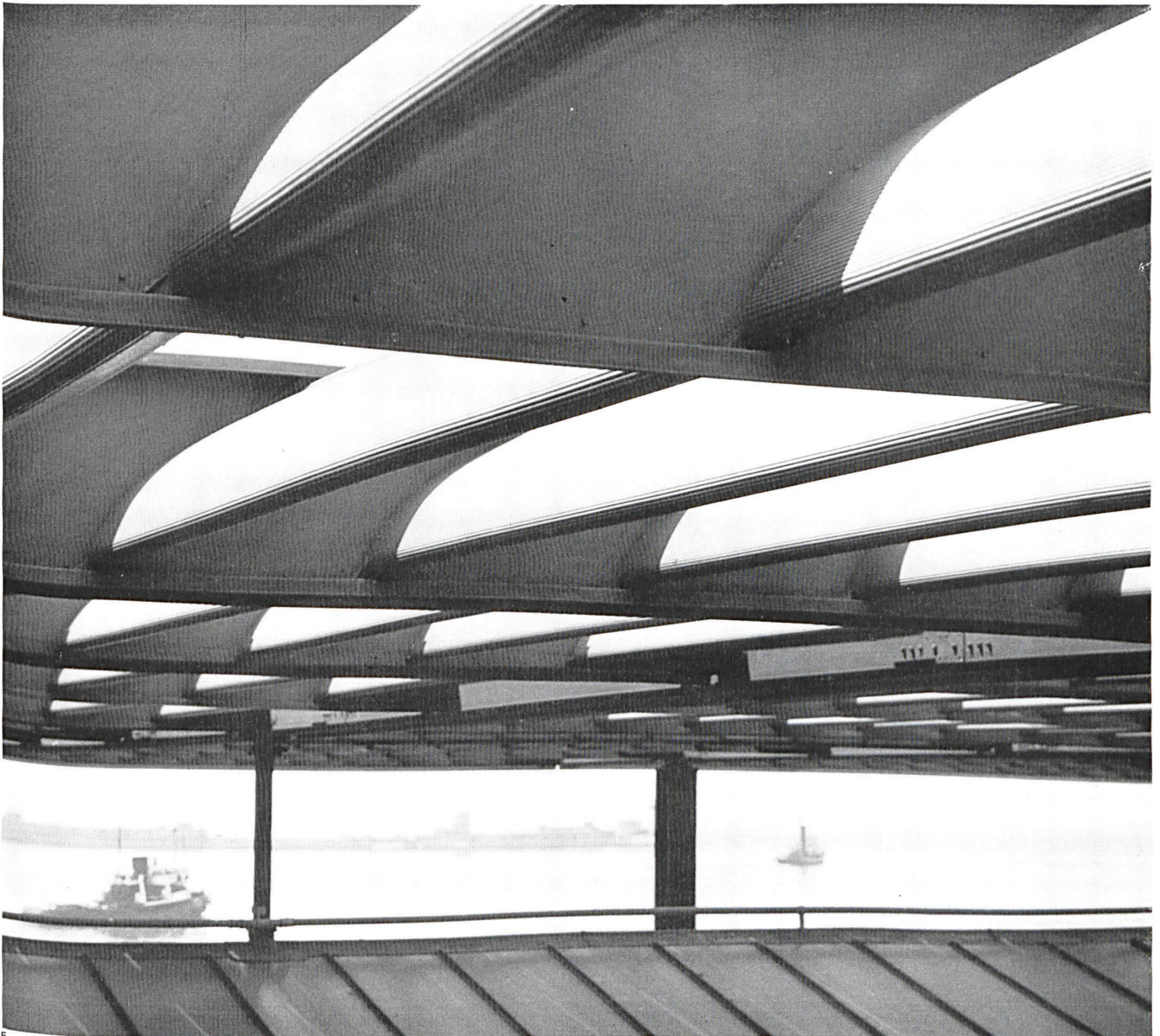
5 Ausschnitt des Sonnenschutzes über dem Glasdach. Détail du brise soleil en lames d'aluminium au des- sus de la verrière. Detail of the aluminium-slatted brise-soleil above the window.
