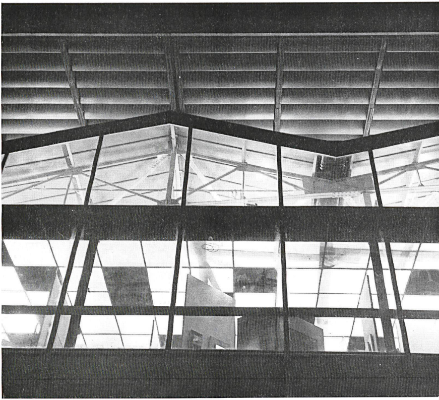
6 Ausschnitt der Nordfassade. Détail de la façade Nord. Detail of the north face.
