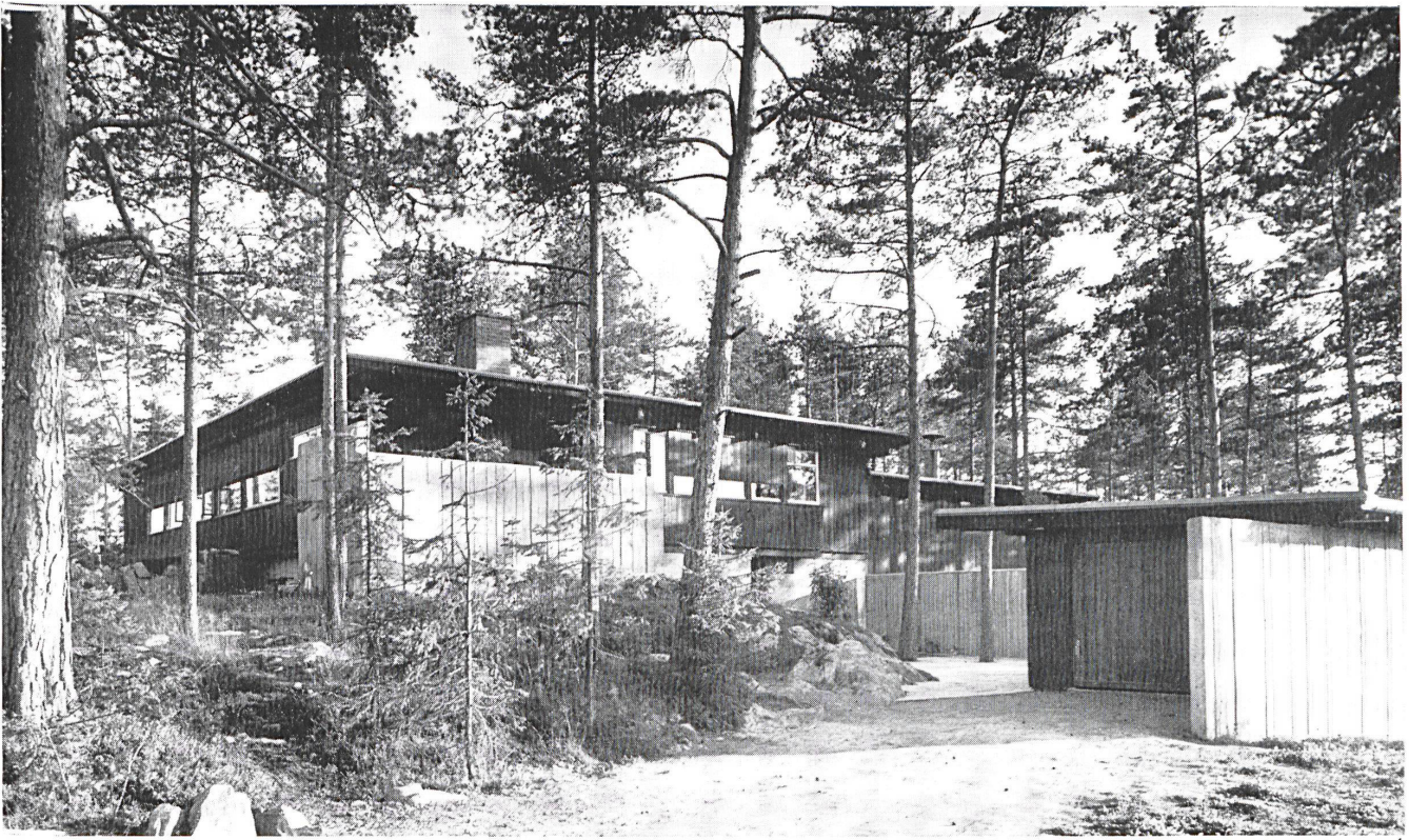
1 Der Eingangshof von Norden, rechts der Garagenbau, im Gartengeschoß des Hauses liegt der ebenerdige Eingang.
