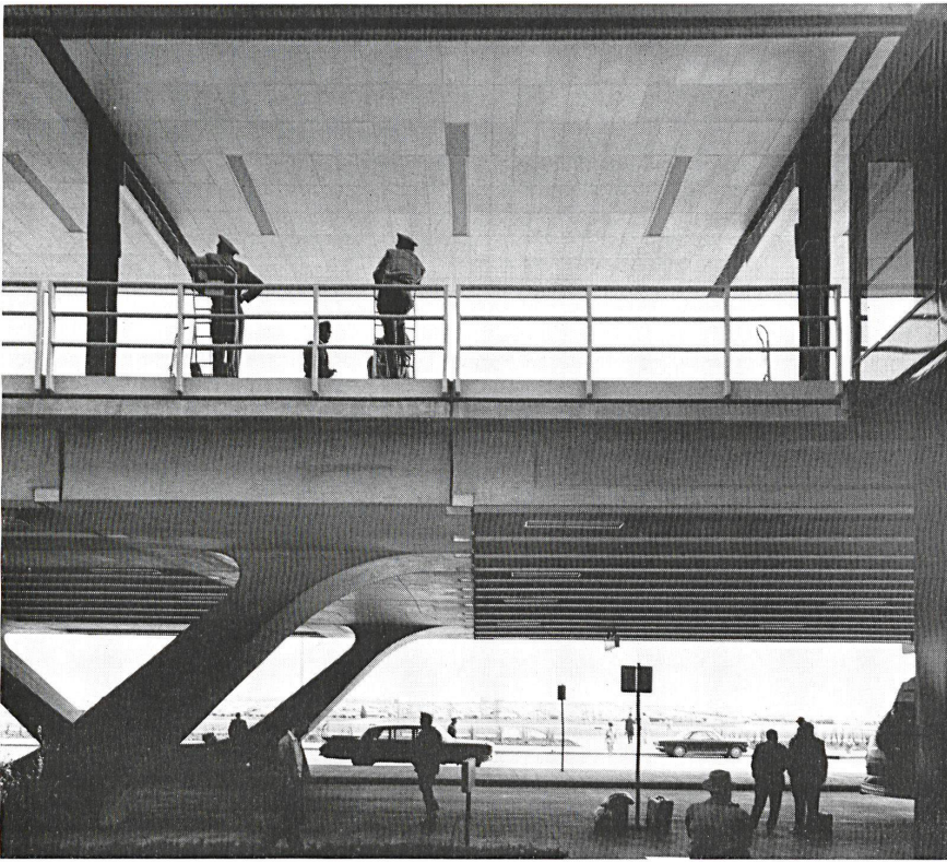
1 Die zweistöckige Zufahrt der Terminusbauwerke, Autozu- und -abfahrt oben und unten. Blick auf den großen zentralen Parkplatz. L'accès des véhicules sur deux niveaux de l'aérogare. Vue sur le grand parking. The two-storey access to the terminal buildings, entrance and exit for cars above and below. View on to the large central parking area.
