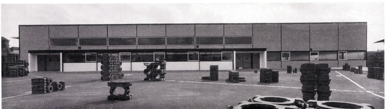
3 Nordostseite mit vorgelagerter Lehrlingswerkstatt. Face nord-est avec atelier des apprentis. Northeast face with apprentice workshop in front.
