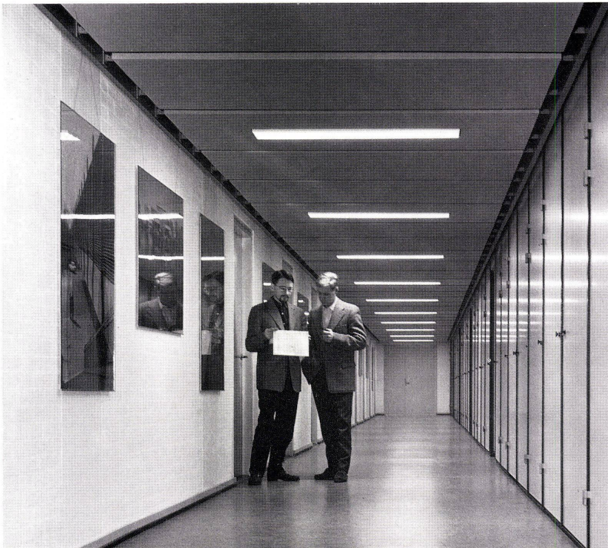
3 Die Deckenelemente in einem Normalkorridor sind teilweise herabgeklappt. Les éléments de plafond d'un couloir type sont rabattus en partie. The ceiling elements in a standard corridor are partially folded back.
