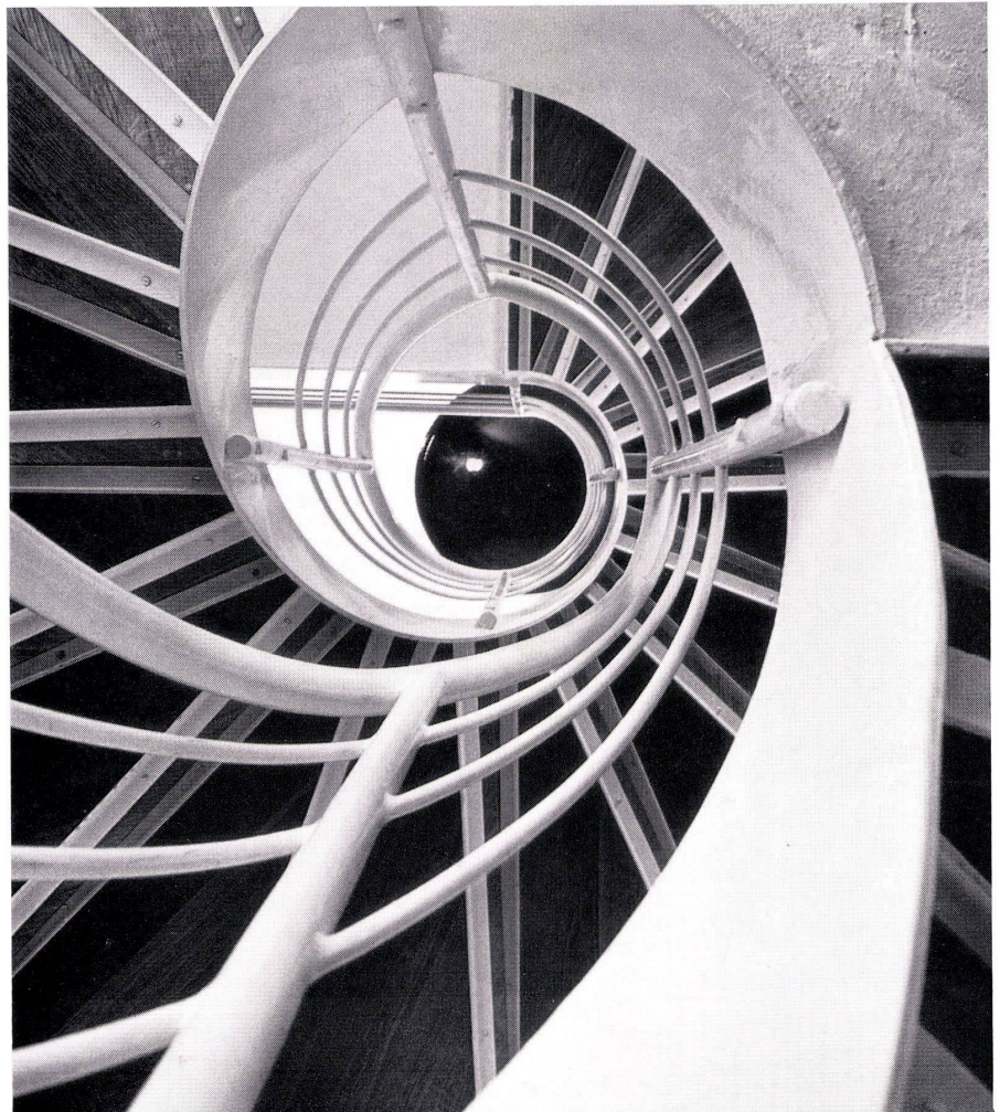
2 Wendeltreppe in Stahl als Geschoßtreppe. Stahlrohr als Geländerpfosten und Handlauf. Colimaçon en acier. Appuis de la balustrade et main- courante en tube d'acier. Spiral staircase of steel. Railings of tubular steel construction.
