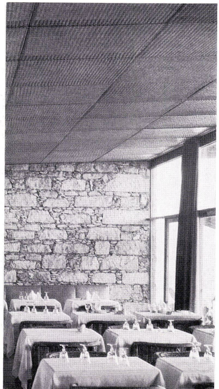
4 Im Speisesaal wirkt eine in ortsüblichem schichtigem Trockenmauerwerk aufgeführte Wand besonders at- traktiv. Mur très décoratif de la salle à manger en pierre sèche traditionnelle du lieu. In the dining room the wall, of local dry-laid masonry, is very attractive.
