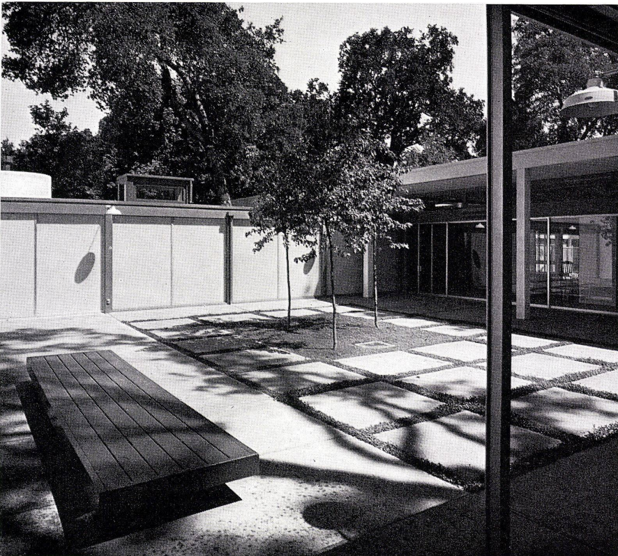
2 Der Wohnhof von Süden aus gesehen. Rechts die Flucht der großen Räume, links der niedrigere Zwischenbau mit den Personalräumen. Cour intérieure vue depuis le sud. A droite on a la perspective des grandes pièces qui se succèdent, à gauche on voit la partie basse avec les chambres de service. Patio seen from south. Right, the sequence of large rooms, the lower intermediate tract with staff rooms.
