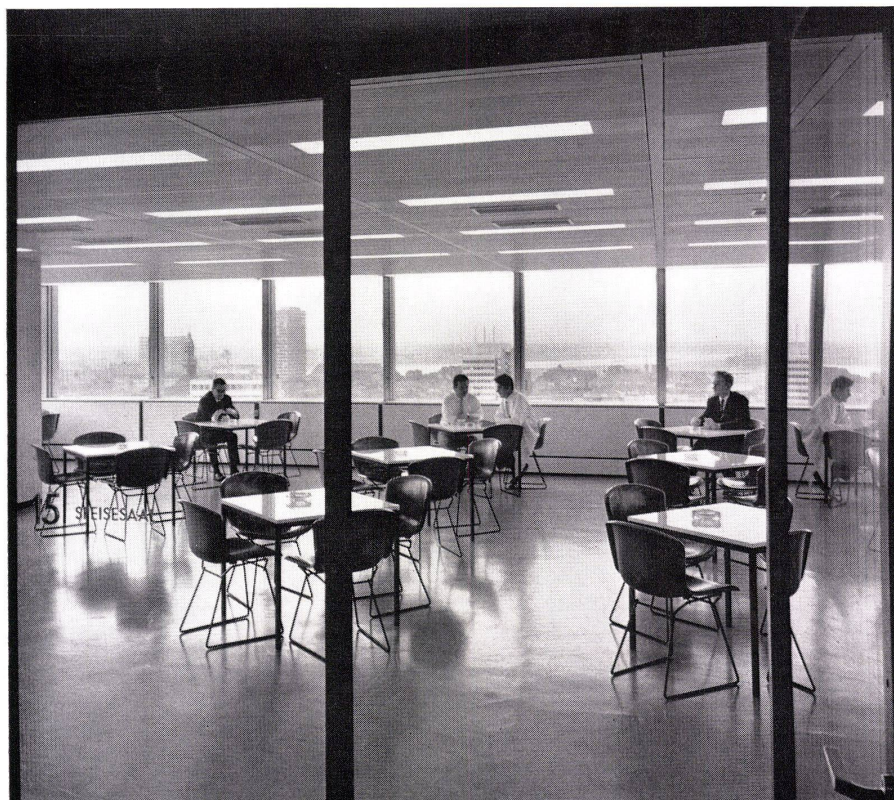
4 Speisesaal im 15. Geschoß. Fußboden Linoleum. Brüstungen: Trägerplatte weiß gespritzt. Decke Zieh- inger Kassetten-Decke.
