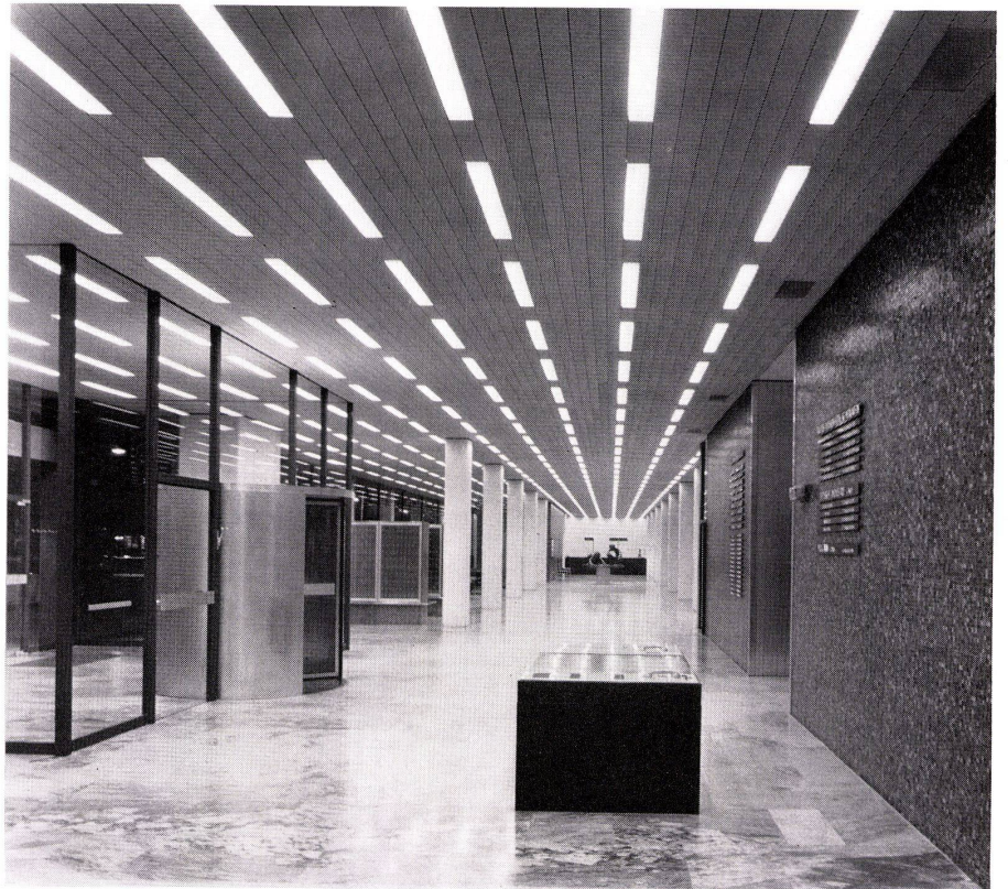
Eingangshalle, Fußboden Naturstein (portugiesischer Trigaxes), Ziehringer Decke. Hall d'entrée, sol en pierre naturelle (Trigaxes du Portugal) plafond absorbant Zieringer. Entrance hall, floor of natural stone (Trigaxes from Portugal), Ziehringer ceiling.
