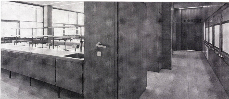
Forschungslabor im Obergeschoß. Installationschacht mit Notbrause, rechts Abzugsgruppe. Laboratoire-type dans étage supérieur. Gaines d'installations avec jet de secours, à droite les places de travail isolées. Standard lab on first floor. Installations duct with emergency jet, right, cubicles.
