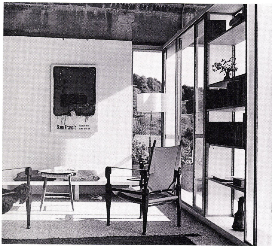
2 Im Wohnzimmer »möbliert« Fassade durch Nischen aus Thermoluxglas, die den Übergang nach außen in Ausschnitte gliedern, die sich bei Bewegung verändern.
