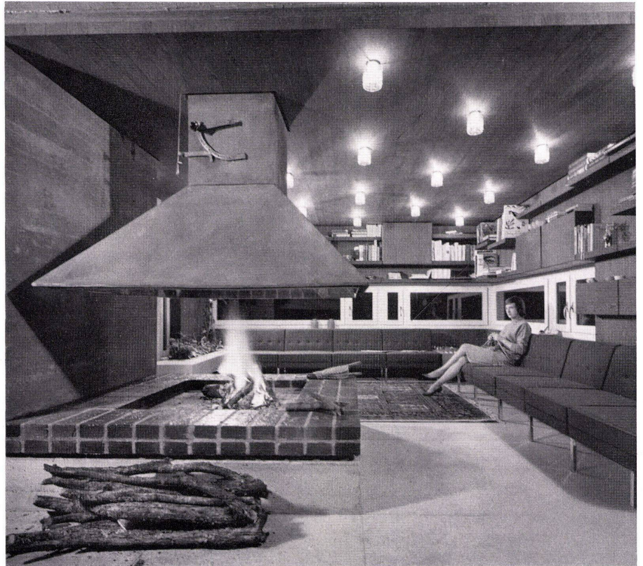
8 disposés sous la bibliothèque. Une fente horizontale se trouve à la hauteur des yeux. Menuiseries en bois apparent, hotte en fonte, cheminée en pierres réfractaires recuites.
