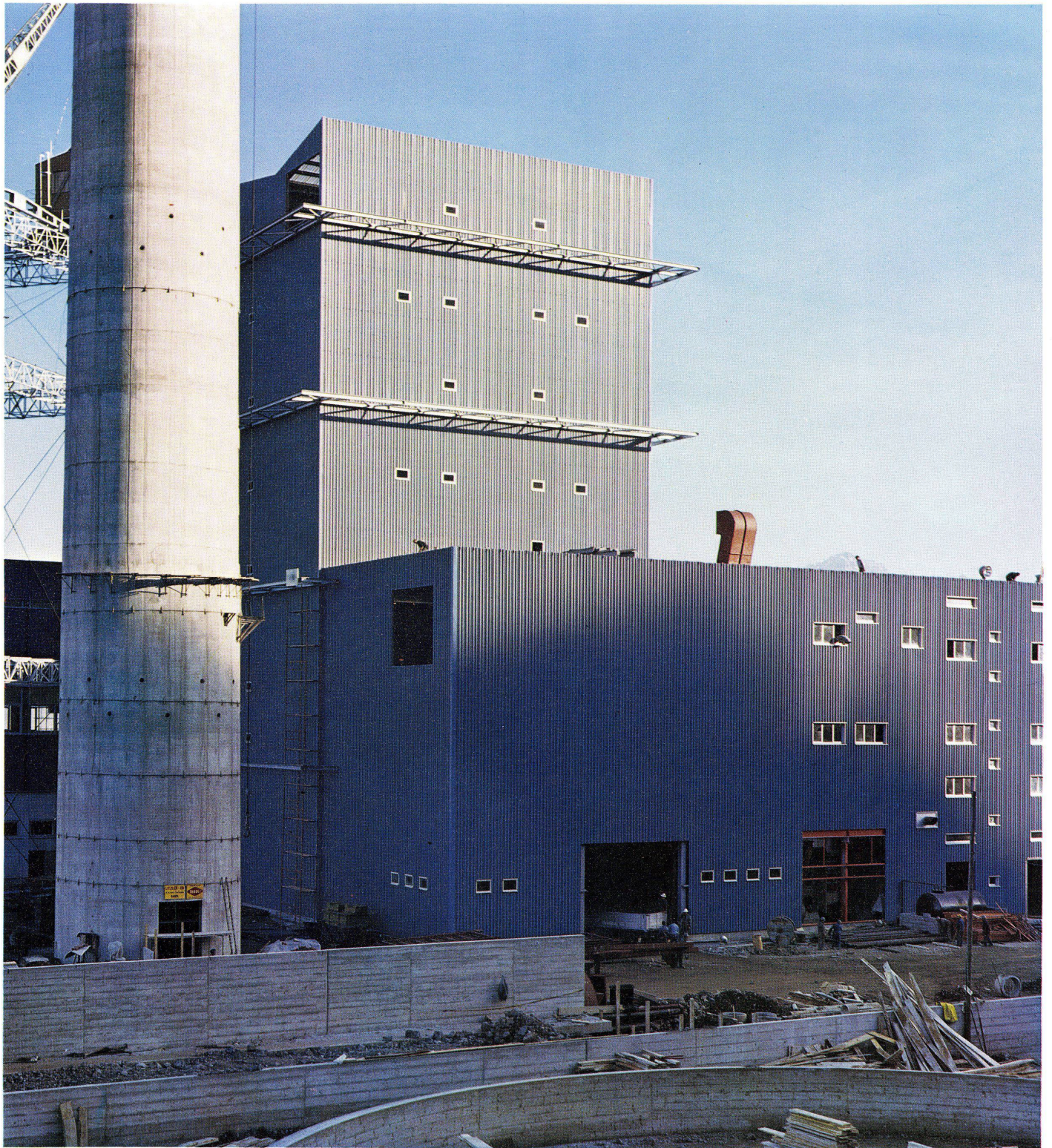
Thermische Kraftzentrale Vouvry mit gewellten Alucolux-Bändern verkleidet
