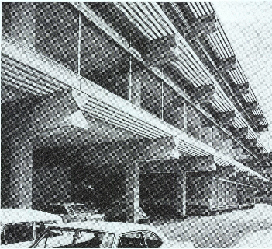
1 Hohe Balken tragen die Decken und die Sonnenblenden. Sie sind an ihren Köpfen so zugespitzt, daß ihre Stirnseite eine Sanduhrform bekommt.
