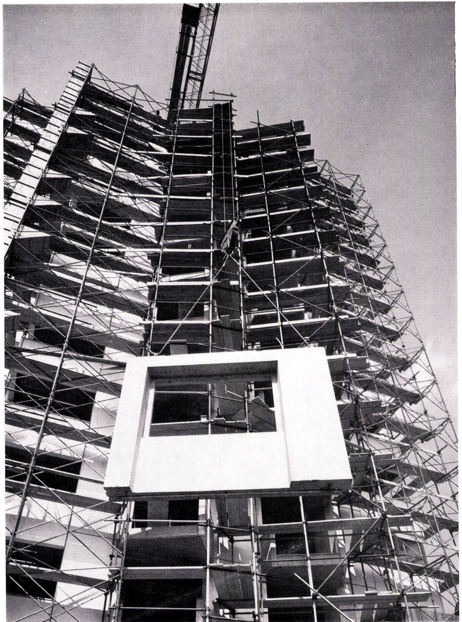
3 + 4 Fassadenelemente in Sandwichkonstruktion 1:30. Eléments de façade en Sandwich. Sandwich face elements.
