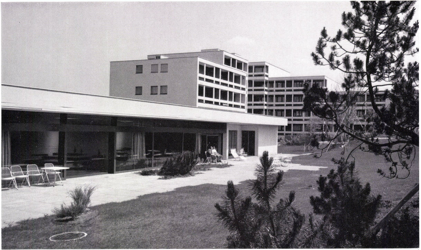
1 Wirtschaftstrakt mit Eßsaalfenstern, hinten der Siedlungsflügel. Aile d'exploitation avec fenêtres du réfectoire, en arrière l'aile de la cité. Utility tract with dining room windows, behind, the colony wing.
