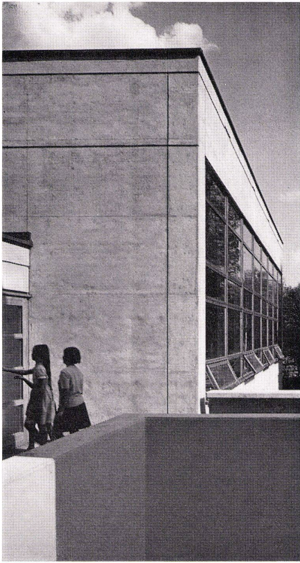
Saaleingang, rechts Turnhalle. Entrée de la salle, à droite la salle de gymnastique. Entrance to hall, right, gymnasium.
