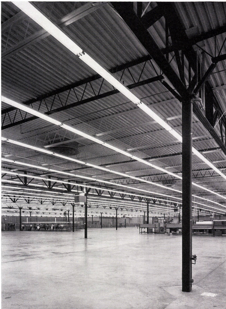
2 Die große Fabrikationshalle mit den Haupt- und Nebengitterträgern. La grande halle de fabrication avec les poutres contrefichées principales et secondaires. The large production shed with the main and sub- sidiary girders.
