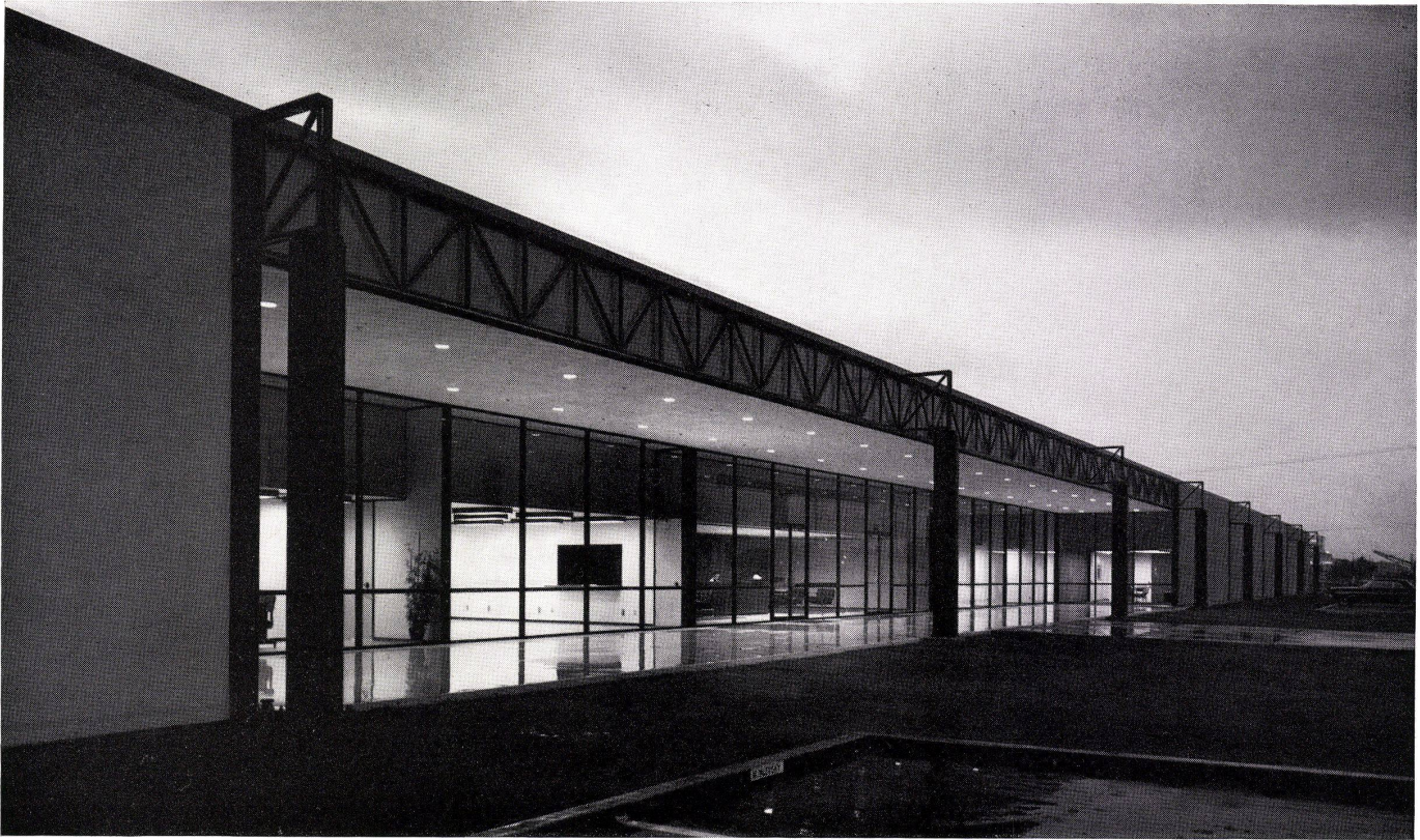
1 Gesamtansicht des Fabrikationsgebäudes von Süden. Vue générale du bâtiment de fabrication depuis le sud. Assembly view of the factory from the south.
