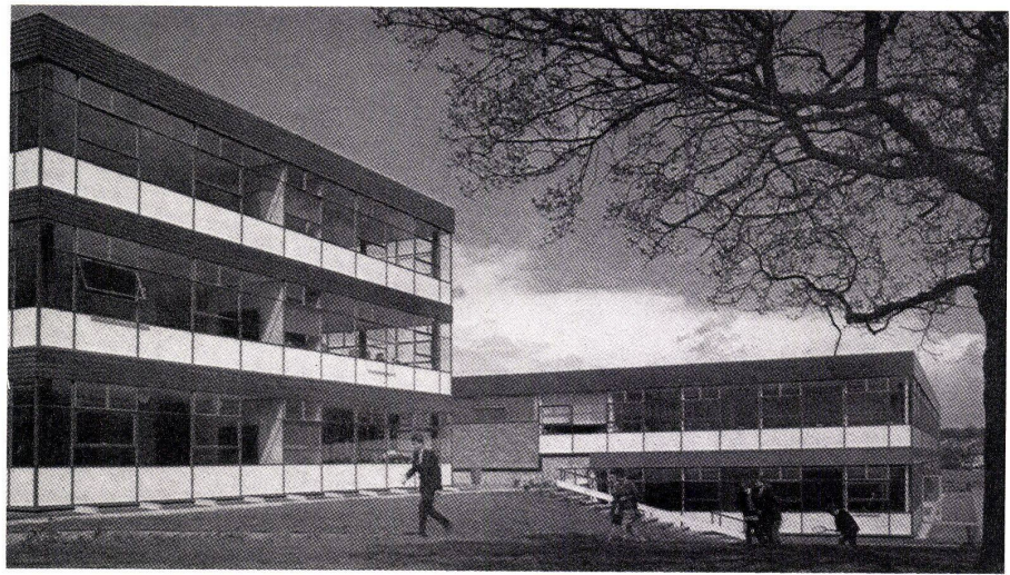
15 Chells Sekundarschule, Stevenage, Hertfordshire. Seac-Stahlbausystem. Ecole secondaire de Chell à Stevenage, Hertfordshire. Système Seac de construction en acier. Chells secondary school, Stevenage, Hertfordshire. Seac steel construction system.
