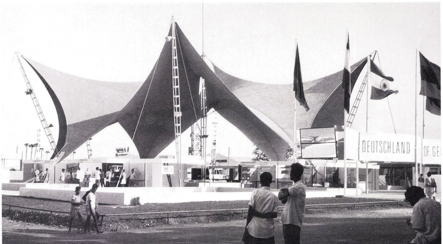
1 Ansicht, Ausführung in Madras 1968. Vue, exécution à Madras 1968. Elevation view, execution in Madras 1968.
