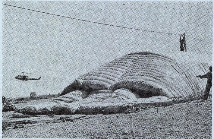
1 Die pneumatischen Konstruktionen sind durch »Nabelschnüre« mit dem Versorgungszentrum verbunden.
