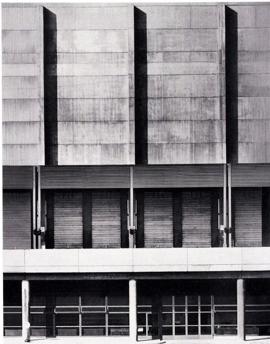
2 Fassadendetail der Müllverbrennungsanstalt. Détail de façade de l'installation d'incinération des ordures ménagères. Elevation detail of the incineration plant.
