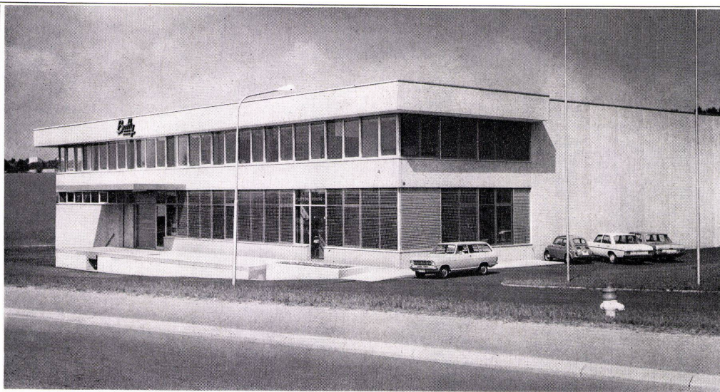
Usine Butty SA Crissier/Lausanne Architectes MM. de Freudenreich & Strobino Avenue de Rumine 22 Lausanne Stores vénitiens Tous-temps à lames bordées 80 mm.
